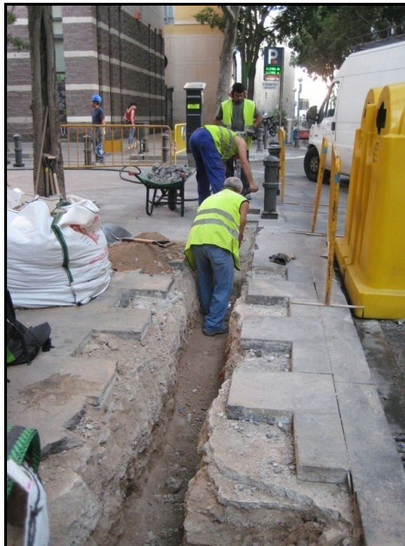
Treballadors de l'empresa Corning rebaixant la rasa
