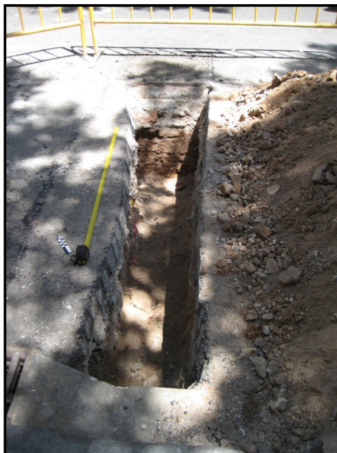
Imatge final del tram transversal de la rasa
