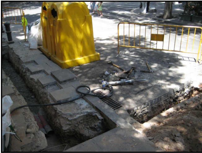
Vista final dels dos trams de la rasa
