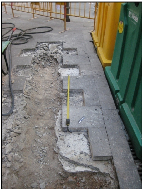
Vista del tram N-S de la rasa on es poden observar els tres primers nivells
